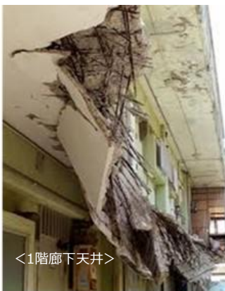
建物の傷みが著しく外壁の剥落、鉄骨の露出などが見られる事例
