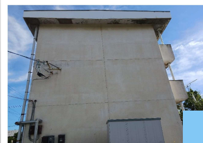
塗装の剥がれがみえます。
