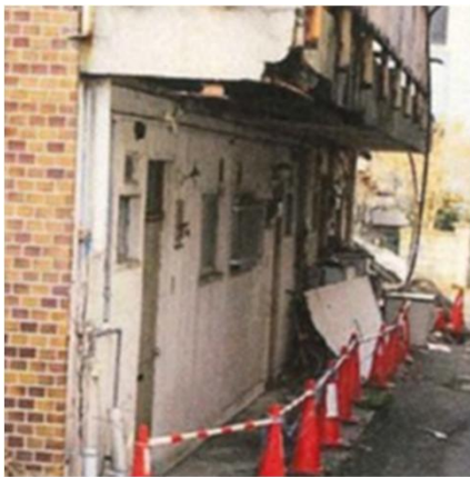
外壁剥落等の危険な状態
